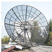
СПОИ-Э – станция приема и обработки данных с геостационарных КА серии Электро-Л в международном формате HRIT в L-диапазоне. Диаметр антенны 3 м.
