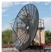
СПОИ-2С – станция приема и обработки данных с геостационарных КА в С-диапазоне. Станция СПОИ-2С позволяет принимать информацию с японского КА Himawari-8. Диаметр антенны 3 м.
